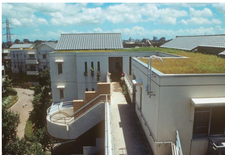
写真1 深沢環境共生住宅の屋上緑化
