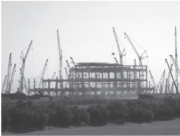
写真1 建設が進むシャープ堺工場
